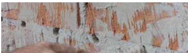
Usuwanie pyłu i pozostałości po wierceniu
