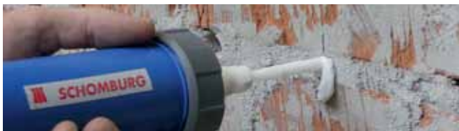
Nakładanie środka AQUAFIN®-i380
