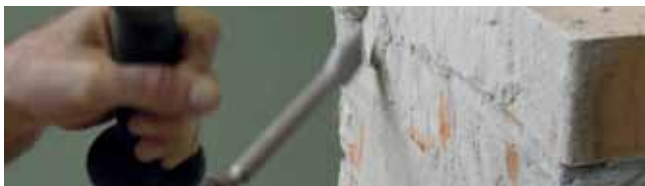
Usuwanie tynku z uszkodzonych obszarów
